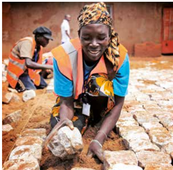
Bujumbura: Les routes pavées sont faciles à entretenir et bien plus durables que les routes goudronnées ou bétonnées. © CTB / Rosalie Colfs
